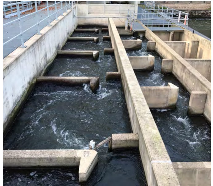
Bild 8: Links: Strömungsmuster in einem RBP Typ C (Beispiel: Birs / Courrendlin JU; Foto: J. Stork), rechts: Strömungsmuster («strömungsdissipierend» – linker Strang und «strömungsstabil» – rechter Strang, nach DWA, 2014) in einem konventionellen Schlitzpass (Beispiel: Mosel / Koblenz, Rheinland-Pfalz; Foto: M. Mende).
