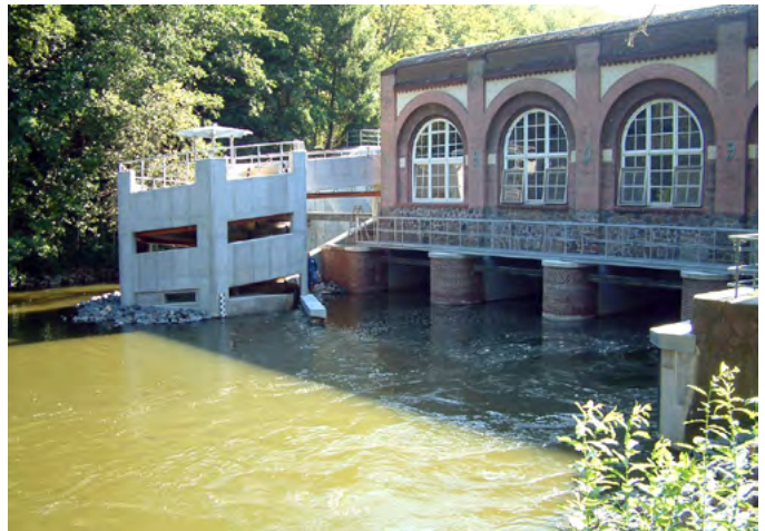
Bild 5: Helix-Turmfischpass an der Schwentine/Schleswig-Holstein (Fotos: E. Kuberski).
