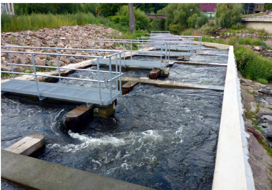
Bild 6: Konventioneller Schlitzpass mit alternierender Beckenführung (Foto: www.ib-handrick.de).
