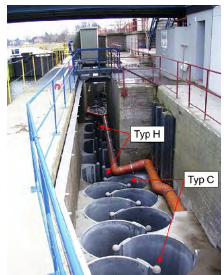
Bild 7: RBP an der Weserstaustufe Drakenburg mit einer Kombination von Typ C und Typ H unmittelbar vor der Inbetriebnahme (Foto: Hersteller, modifiziert).
