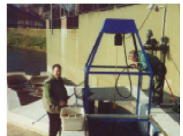
Hebewerk der Kontrollreue in Hameln/Weser
